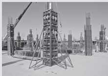
Casseforme per pilastri
