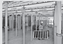
Casseforme per solai
