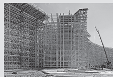
Impalcature di sostegno
