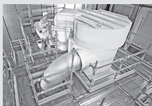
Impalcature di servizio per industria
