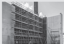
Costruzione di impalcature di servizio
