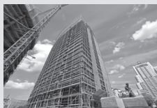
Facciata con impalcature di servizio
