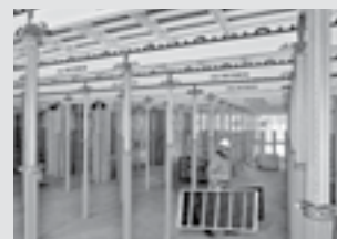
Casseforme per solai
