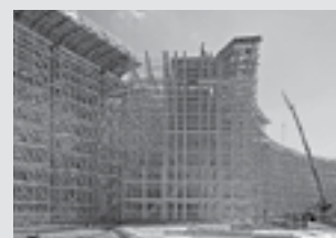
Impalcature di sostegno
