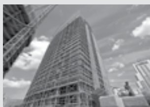
Ponteggi di facciata
