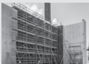
Impalcature di servizio
