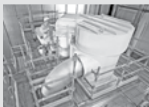
Ponteggi per l'industriale
