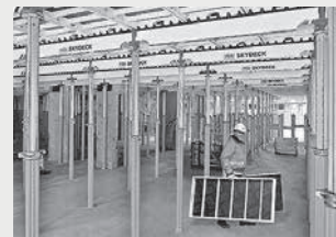
Casseforme per solai
