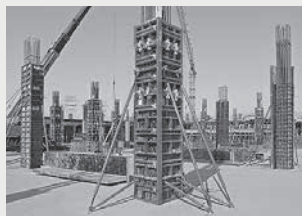
Casseforme per pilastri
