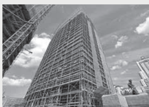
Facciata con impalcature di servizio
