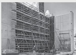
Costruzione di impalcature di servizio
