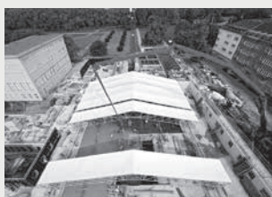
Impalcature di protezione
