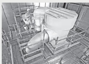
Impalcature di servizio per industria
