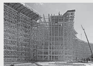
Impalcature di sostegno
