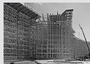
Impalcature di sostegno
