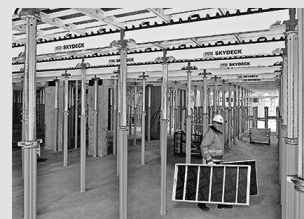
Casseforme per solai
