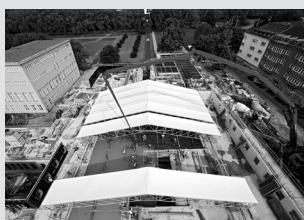
Impalcature di protezione
