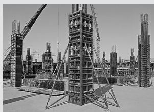
Casseforme per pilastri
