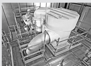
Impalcature di servizio per industria
