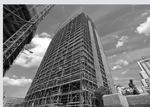
Impalcature di servizio per facciate
