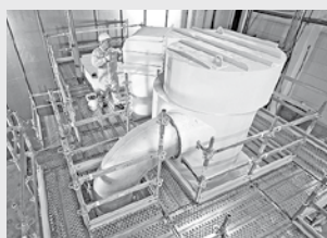
Ponteggi per l'industriale
