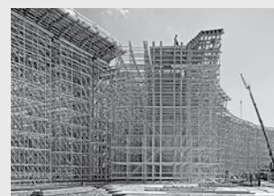
Impalcature di sostegno
