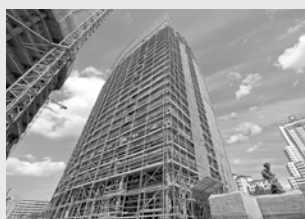
Ponteggi di facciata
