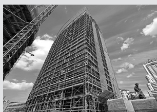
Impalcature di servizio per facciata
