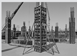
Cassaforma per pilastro
