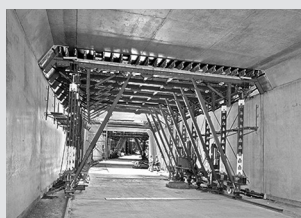
Cassaforma per tunnel
