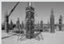
Casseforme per pilastri
