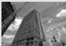
Ponteggi di facciata
