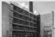
Impalcature di servizio
