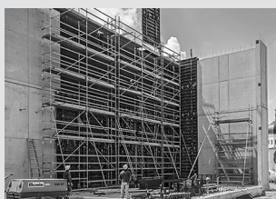
Impalcature di servizio per l'edilizia
