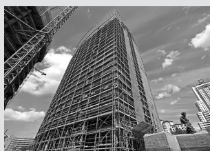
Impalcature di servizio per facciate
