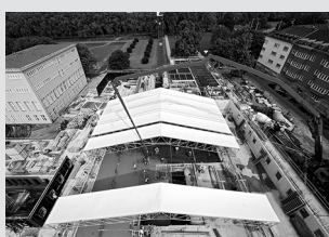
Impalcature di protezione
