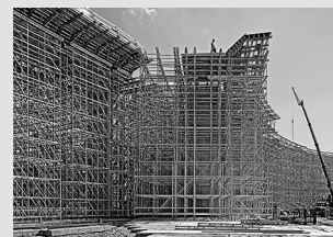
Impalcature di sostegno
