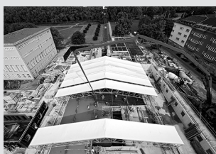
Impalcature di protezione
