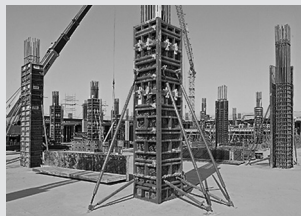
Casseforme per pilastri
