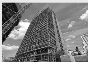
Facciata con impalcature di servizio
