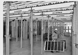
Casseforme per solai
