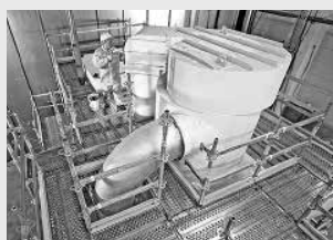
Impalcature di servizio per industria
