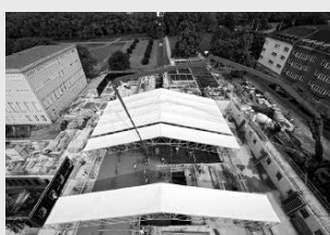
Impalcature di protezione
