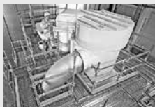
Ponteggi per l'industriale
