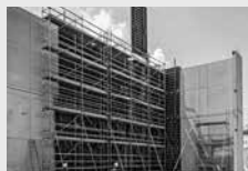
Impalcature di servizio
