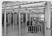
Casseforme per solai
