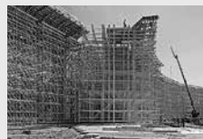
Impalcature di sostegno
