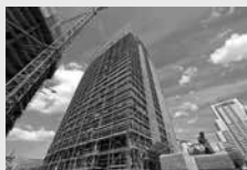
Ponteggi di facciata
