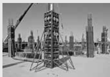
Casseforme per pilastri
