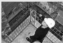
Sistemi di sicurezza
