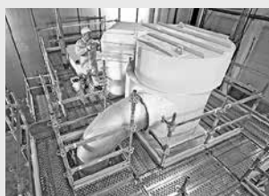
Ponteggi per l'industriale
