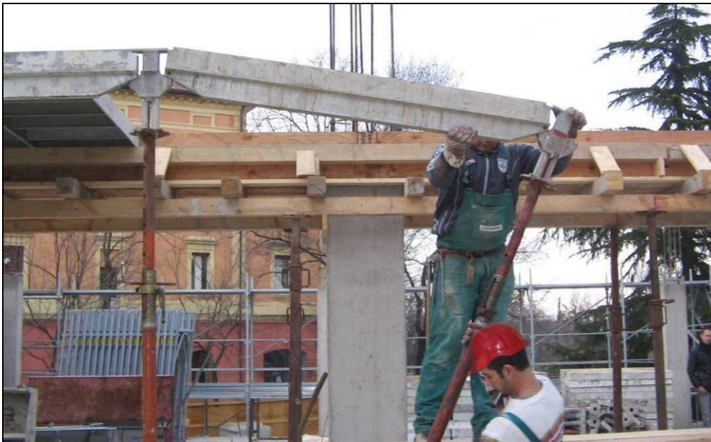
Immagine 4: Montaggio della trave del sistema Modul.
