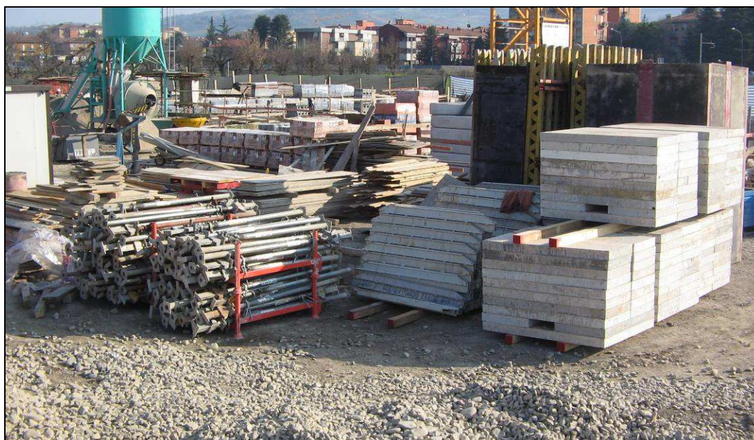
Immagine 3: Accatastamento e stoccaggio dei componenti del sistema Modul.
