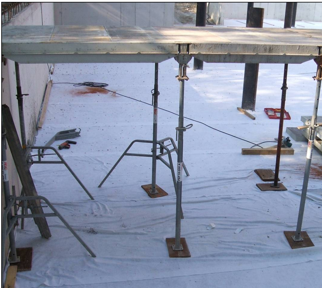
Immagine 2: Utilizzo del treppiede per solai Modul
