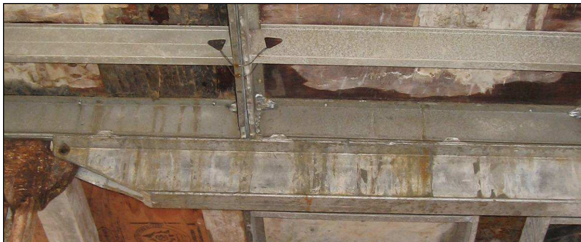
Immagine 7: Legatura dei pannelli di estremità del sistema Modul.
