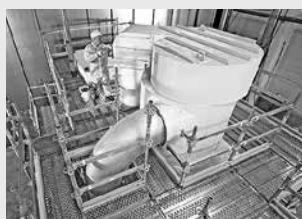
Ponteggi per l'industriale
