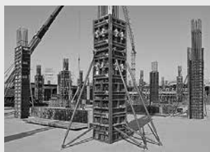
Casseforme per pilastri
